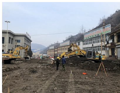
九院沙河道路西延快速化改造工程正在火热进行中,随着冬
