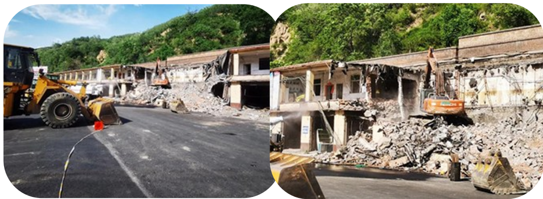
5月29日,位于官地广场的一座地标性建筑官地矿大车队,在挖掘机的隆隆声中被拆除,为九院沙河西延道路快速化改造做出贡献。
