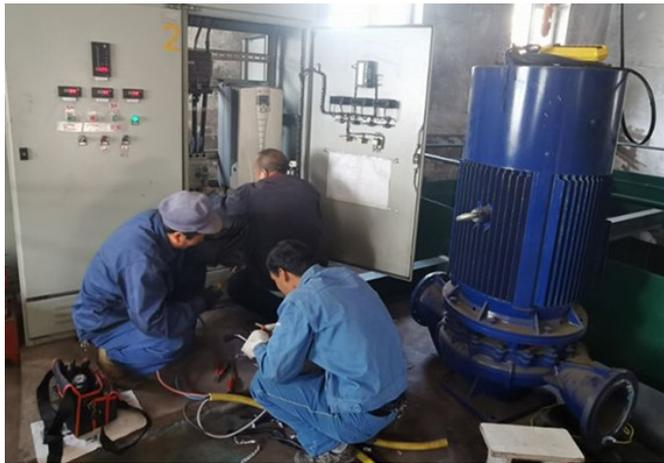
固,对设备设施进行除尘、除锈。此次改造做到了投入最小化、效益最大化,既消除了泵房安全隐患,进一步优化了供电系统,又确保了矿区供水安全稳定可靠运行。
