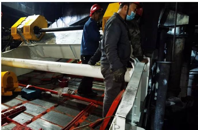
近日,官地矿选煤厂305、306精煤脱介筛提前2天完成更换组装,进一步提高了该厂装备水平和生产效率。
