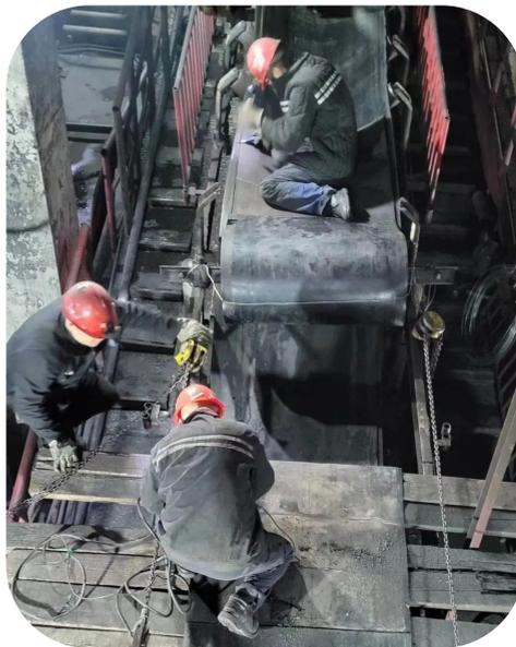
1月5日,马兰矿选煤厂准备车间利用停机检修时间,对有运输安全隐患的281输送机皮带进行更换。
