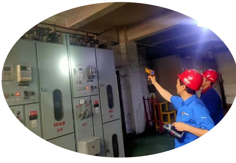
为保障夏季电气设备安全运行,8月1日,镇城底选煤厂机电车间对高低压配电室电气设备进行详细巡检和测温。
