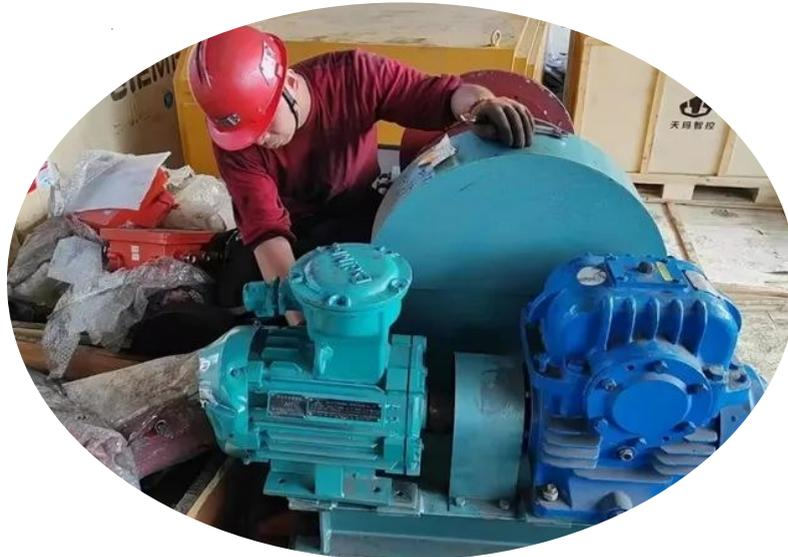
近日,屯兰矿皮带队检修人员在日常巡视中发现,南三下组煤涨紧绞车电机异常,为不影响原煤正常拉运任务,皮带队立即对其采取更换处理。
