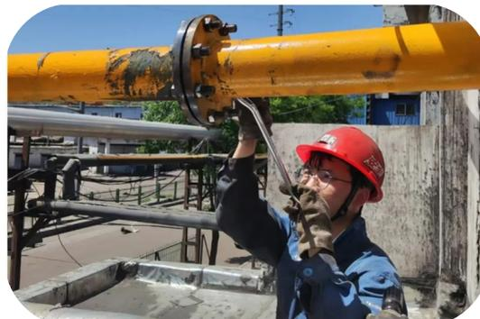
屯兰选煤厂准备车间风管由于裸露在外,常年风吹日晒雨淋,致使风管锈蚀严重,出现漏风现象,影响正常使用。为了消除这一安全隐患,日前,车间组织维检人员对其进行更换。
