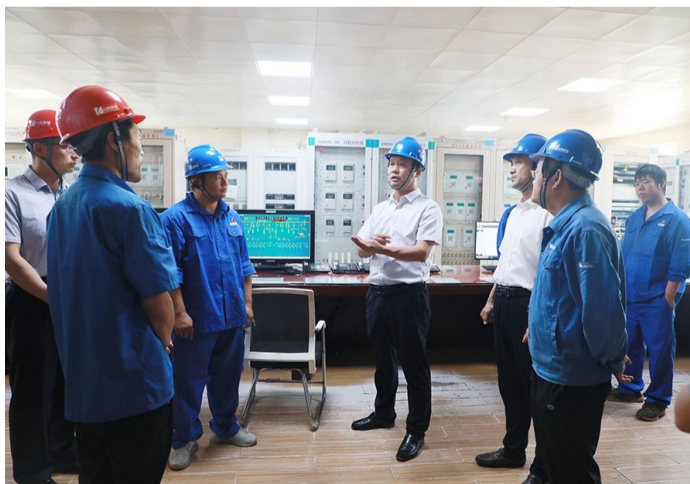
6月28日,山西焦煤西山煤电党委书记、董事长王晓东到东曲羊圈港35KV变电站和瓦斯发电项目督导安全工作(见图)。王
