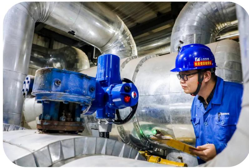
随着冬季供暖的来临,10月18日,武乡电厂设备维护部职工对改造后的供热首站设备注水进行检查,排查管道、阀门漏点,确保供热设备安全稳定运行。
