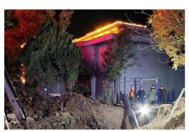
上游污水,再用挖掘机开挖出长20 米、宽3米、深5米的沟槽,终于找出 污水管道破裂位置。随后根据管 道破损情况,施工人员将原破损管 道更换为长20米、直径500毫米的 螺旋波纹管,再用水稳分层回填夯
