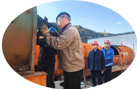
鉴于矿厂风机房2#主通风机在运行过程中出现电机振动值偏高的情况,西铭矿从10月下旬开始,按照既定的安全技术组织措施与应急预案,有条不紊地对矿厂风机房2#主通风机一级电机、二级电机的轮毂及风叶进行检修,对其轴承进行更换。
