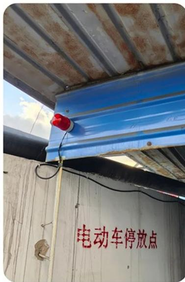
近日,为杜绝煤泥水外溢,造成环保事件,屯兰选煤厂煤泥水车间在612浓缩池西侧和生产仓东侧防洪沟安装了两套声光报警装置。
