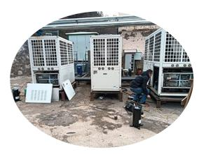
12月19日上午,临汾公司后勤服务中心检修人员 在对办公楼、机电队等区域供暖设备检查时,发现上述 区域供暖设备中的部分压缩机损坏,检修人员立即着 手修理,同时立即联系售后方,并启动应急预案,在检 修人员的努力下,在下午15点恢复了该区域供暖。下 一步,该后勤服务中心将密切关注供暖运行情况,为矿 井温暖讨冬做好后勤保障工作。
