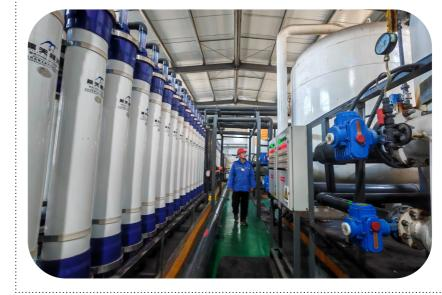
3月18日,东曲矿污水处理厂职工正在巡视自超滤水返井系统,以确保系统安全稳定运行。
