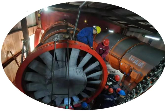
随着井下工作面的不断延伸,矿井通风量需求不断增大,为满足矿井安全生产需求,提升井下通风安全质量,保障生产平稳运行,近日,马兰矿更换麻家口主通风机2#风机风叶铜环。
