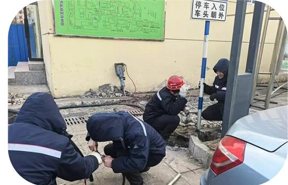
1月12日,镇城底矿选煤厂机电车间在例行巡检中发现,会议中心至压滤车间道路东侧的路灯照明电缆断裂破损,该路段路灯随即无法正常工作,给夜班职工上下班通行带来安全隐患。
