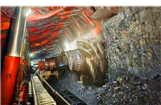
采煤机稳步割煤作业
